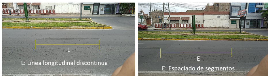
Figura 3 – Línea longitudinal y espaciado de segmentos de tramo
